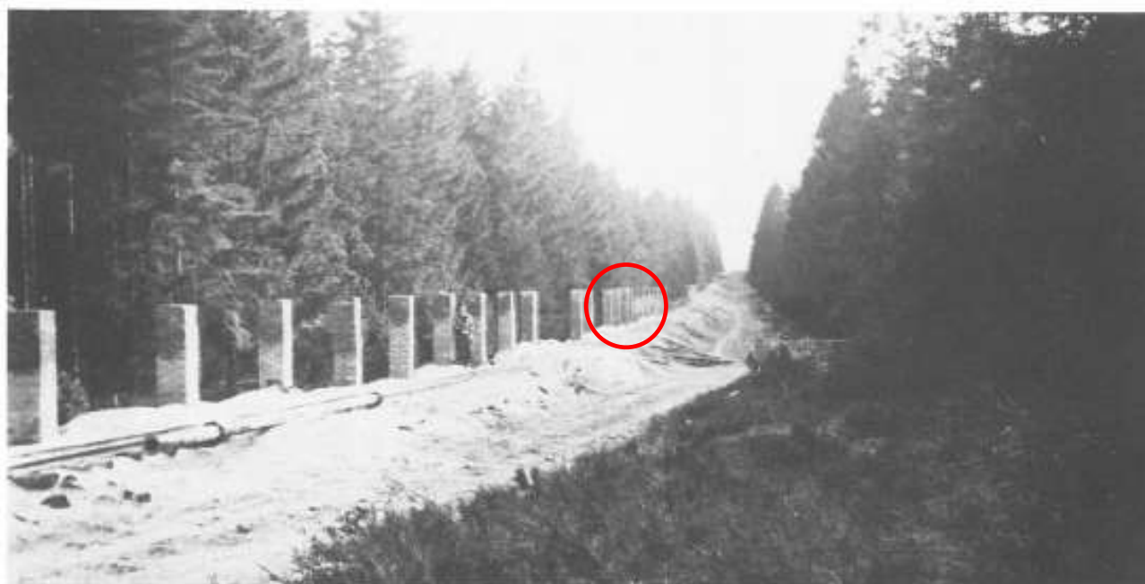
Pillerne, som skulle bære rørledningen ned gennem den omtalte sænkning i den østlige del af Frederikshåbs plantage.
